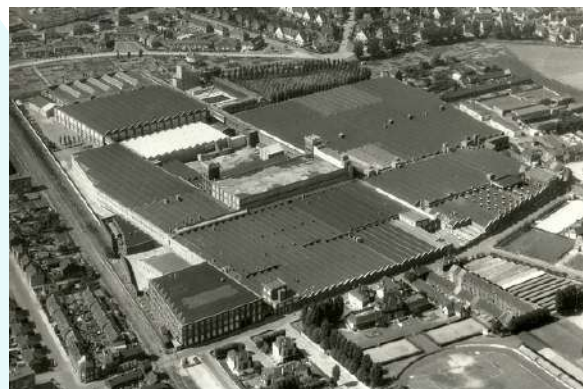
Vue aérienne de la Lainière de Roubaix
