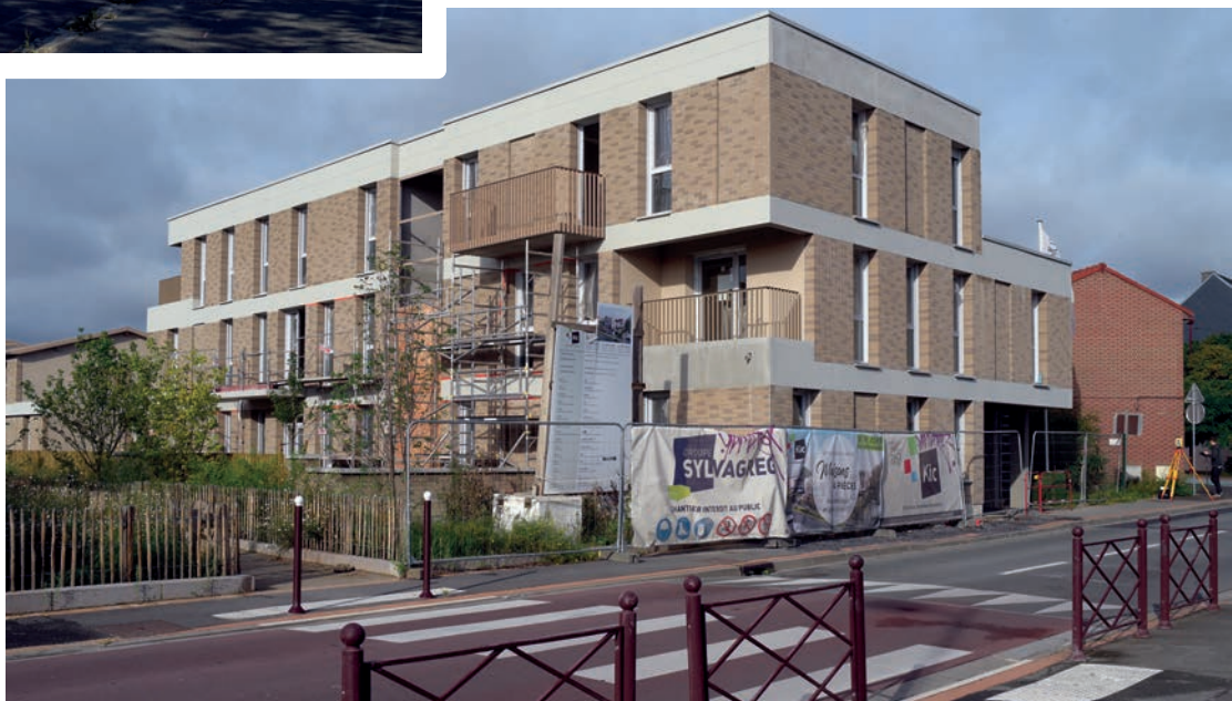
Nouvel immeuble au Crétinier face à l'école Condorcet.
